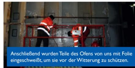
Anschließend wurden Teile des Ofens von uns mit Folie eingeschweißt, um sie vor der Witterung zu schützen.
